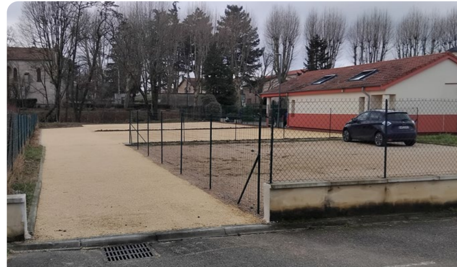
Un nouveau parking derrière l'école
