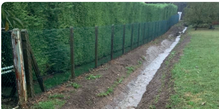
Curage des fossés
